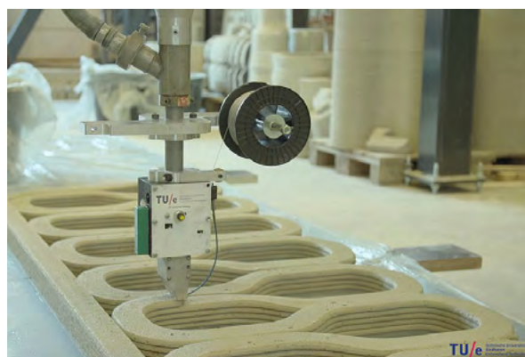
In de Nijmeegse wijk Dukenburg wordt gewerkt aan 3D-betongedrupte bruggen in de openbare ruimte, waarmee wordt bespaard op grondstoffen (foto: gemeente Nijmegen)
